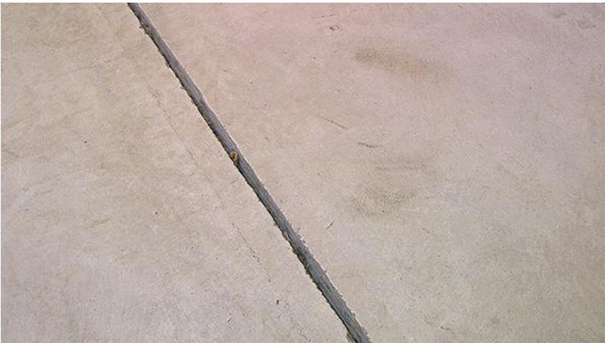
**Las juntas Frías.** Son aquellas grietas relevantes que se forman en la unión de un techo viejo con un nuevo. En estos casos se tiene que repicar o abrir esa unión para hacer una junta de por lo menos una (1) pulgada de ancho por una pulgada (1) de profundidad.
