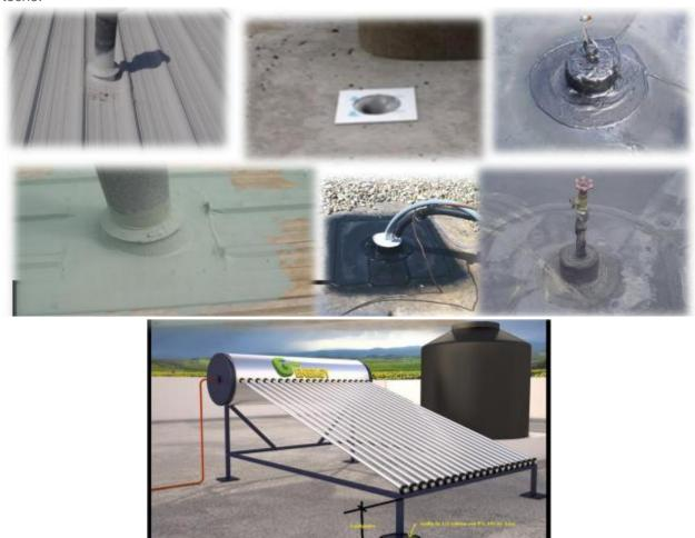
Igualmente las patas de los calentadores o placas solares tienen que ser protegidas con anillas de seguridad debidamente cubiertas con DERMAFILL. Estos, al igual que cualquier otros puntos son los lugares en los techos que originan filtraciones. Asegúrese de sellarlos muy bien, antes de hacer la impermeabilización.
