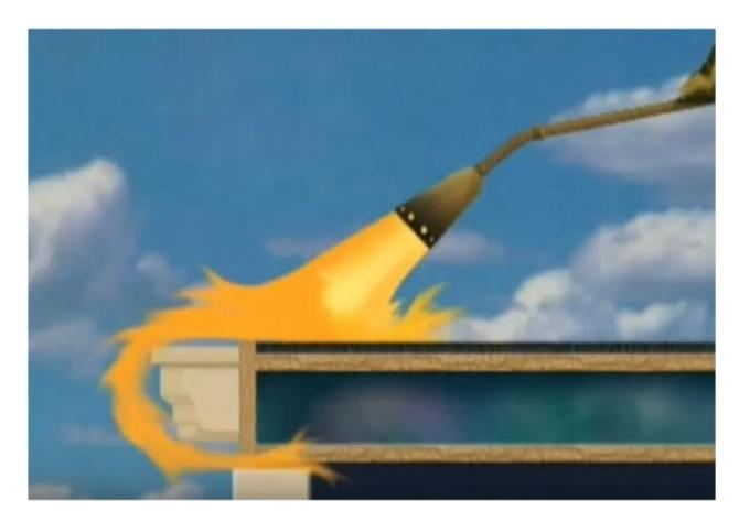
El Soplete. Los peligros del soplete en un trabajo de impermeabilización de techos. Un contratista de techo debe estar debidamente entrenado antes de manejar un soplete. Existen tantos riesgos que pueden originar un incendio que se hace indispensable saber manejar un soplete antes de hacer un trabajo de impermeabilización de techo.
