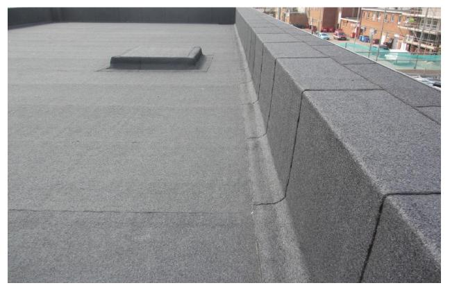
En la foto un trabajo Monocapa realizado con una membrana INDEX de ASSA.
