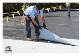
Las membranas autoadhesivas son mas fáciles de aplicar pero se requiere de una concientización mas enfocada a la preparación de la superficie. Muchos contratista de soplete instalan estas membranas sin preparar la superficie como se amerita.
