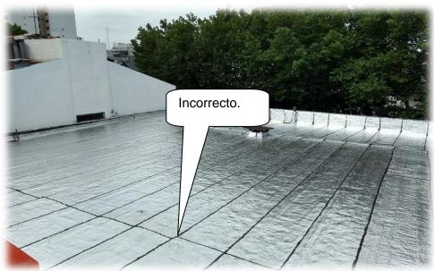
☐ Tome tiempo en los detalles para entregar un trabajo estéticamente atractivo. Pinte las áreas negras en los solapes o cualquier otro lugar con aluminio líquido. Haga cortes en forma redonda en los detalles de las proyecciones en el techo o áreas similares.
