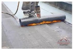
Membranas adheridas con soplete. En la foto de una instalación de soplete podemos ver la cantidad de fuego que teneos que darle a la membrana para que se pueda adherir a la superficie.
