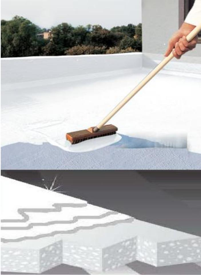
**REMOCION:** Se deberá remover todo material existente en malas condiciones o que no esté bien adherido a la superficie. Las remociones se realizarán simultáneamente con el sellado de grietas de manera que no se produzcan filtraciones al interior del edificio. Usar PG-400 o macilla acrílica y malla de Fiberglass para grietas y penetraciones. Remociones a quedarse podrían invalidar la garantía. Consulte a Assa previamente.
