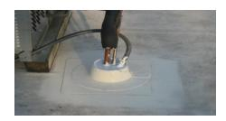
6. Las penetraciones, después de selladas, deben quedar como muestra la imagen de la izquierda. Use una anilla PVC de Assa de una pulgada de altura rellena con macilla acrílica. Así como en la imagen selle las patas del calentador solar, los anclajes de los aires o cualquier otro, tubos de plomería, tubos eléctricos, base de antenas, cablerías que surjan de la superficie y cualquier otro de similar naturaleza.
