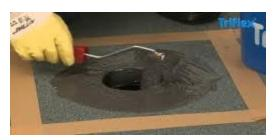
7. El sellado de los desagües se realiza usando el mismo sellador ElastoCover y una malla de Fiberglass para reforzar. Vea algunos videos en la página de Assa o llámenos para darle mas detalles de este sellado. Tanto los desagües verticales como los horizontales de los pretiles tienen que ser debidamente sellados antes de aplicar el tratamiento ElastoCover.
