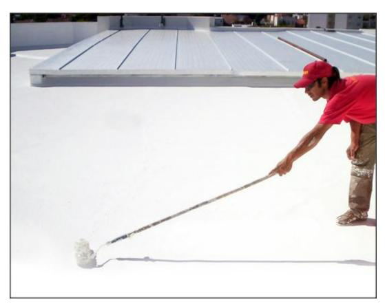
Mantenimientos. Se debe ofrecer un mantenimiento cada 2 años para aplicar para la garantía de por vida. En este mantenimiento se aplicarán dos capas de ElastoCover blanco en forma de cruz en toda la superficie. Se deben resisar todas las penetraciones que permanezcan 100% selladas como en su origen.
