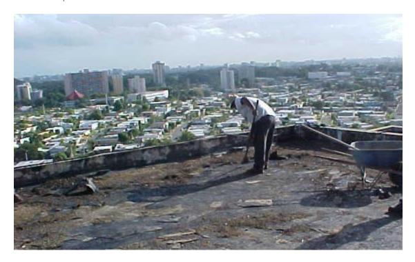
1. Remueva de su techo todo material existente que no esté bien adherido a la superficie. Tratamientos existentes asfálticos, elastoméricos o acrílicos deben ser removidos en su totalidad si es posible. Solo puede quedarse aquel material que este bien adherido.
